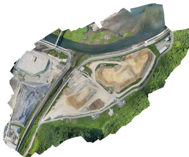
RWC 会場の建設現場
