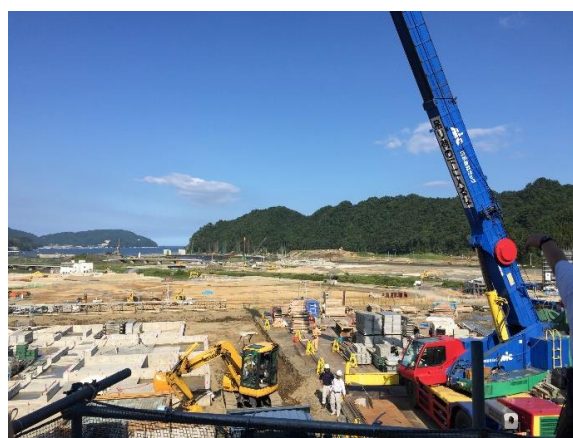
(建設中の幼稚園棟)
