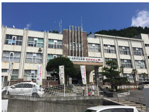
（釜石市本庁舎）
